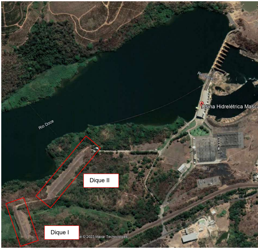
Figura 2. Diques da UHE Mascarenhas. Fonte: Google Earth. Acesso em 31MAR2023.
