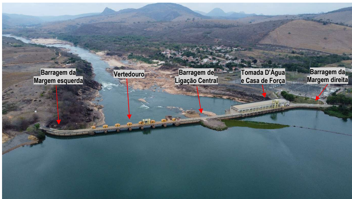
Figura 1. Vista à Montante da UHE Mascarenhas.
